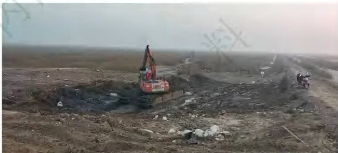
项目施工现场
