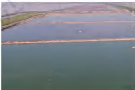
大丰四卯西闸北生态修复项目（修复前）
