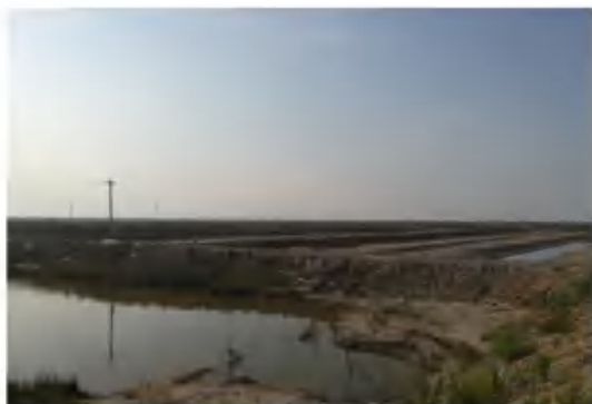
响水旭强项目修复前
