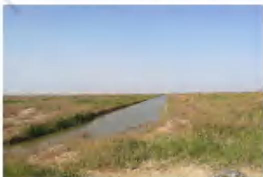
射阳 1 号水库修复前
